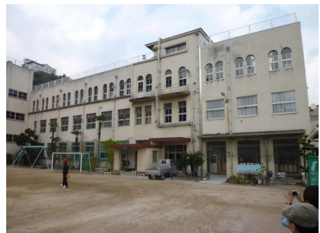
土堂小学校校舎
