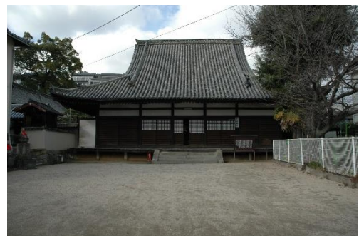
常称寺本堂（重要文化財）
