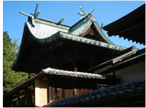
田熊八幡神社本殿
