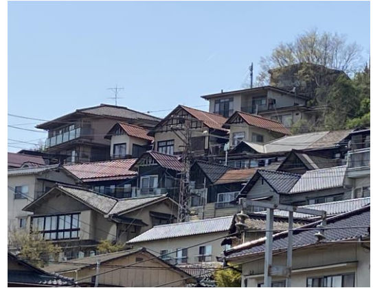
勾配が揃った屋根の連なり（西土堂町）
