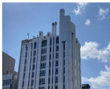
排水管や空調ダクトをデザインの一部分に組み込んでいる建築物の例
