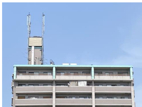
スカイラインや建築物の外観に影響を与えている基地局アンテナの例
