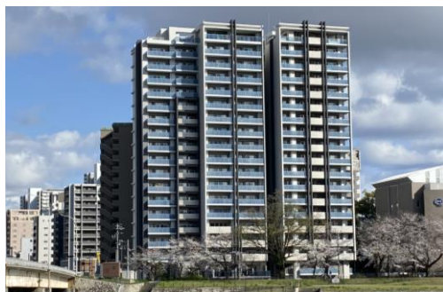
複数の色彩と壁面の凹凸を組み合わせ分節化している建築物の例
