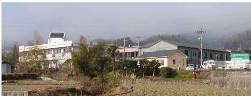
増設された建築物の色彩に一体感が見られない施設群
