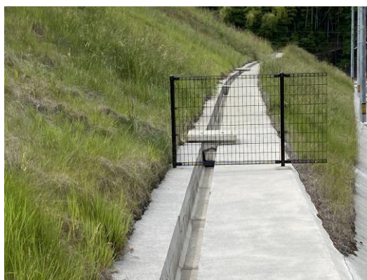
緑化による法面の保護・修景
