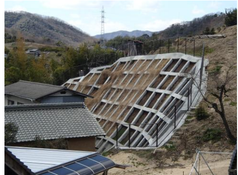
急傾斜地崩壊対策箇所
