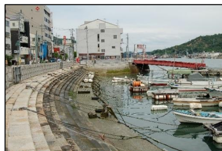
高潮対策整備後の尾道水道護岸
