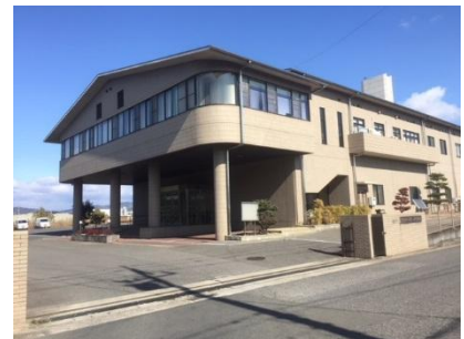
おのみち地区し尿処理場
