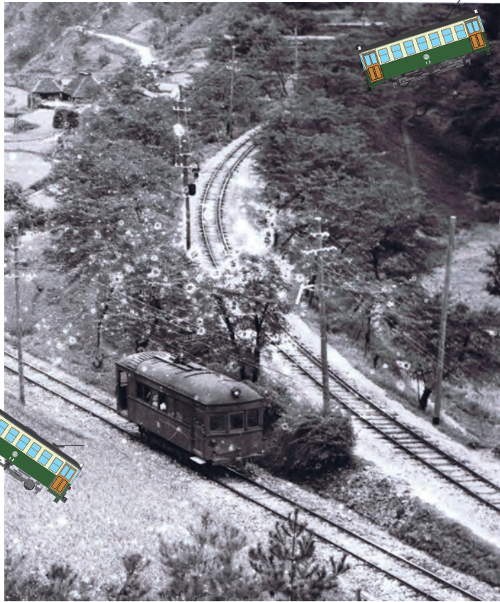
諸原区間に見たスイッチバック 戦前・中西正吾氏撮影 右手線路が尾道方面 両線が交わる右下の線路の先に諸原駅が位置する。
