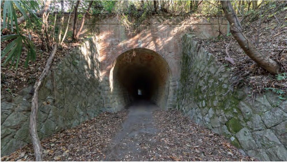
木ノ庄町末政に残る尾道鉄道第4号トンネルの遺構 令和5年（2023）11月14日・西川真理子氏撮影 トンネルの総延長は80mで、内部で緩やかにカーブしている。坑門は煉瓦と石を併用して築造され、煉瓦の積み方はフランドル（フランス）積み形式。参照：八幡浩二「産業考古学からみた尾道鉄道」『タイムスリップ・レール・オノテツ—尾道鉄道データ・ファイル—』所収（尾道学研究会・2011年刊）
