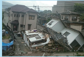
▲熊本地震で建物が崩れた様子：本市撮影
