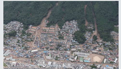
平成26年8月に広島市で発生した大規模土砂災害 出典：国土地理院ウェブサイト
