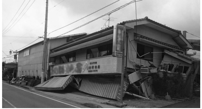
▲ 4月に発生した熊本地震では、昭和56年以前に建てられた旧耐震基準の家屋に被害が集中していました。(本市撮影)
