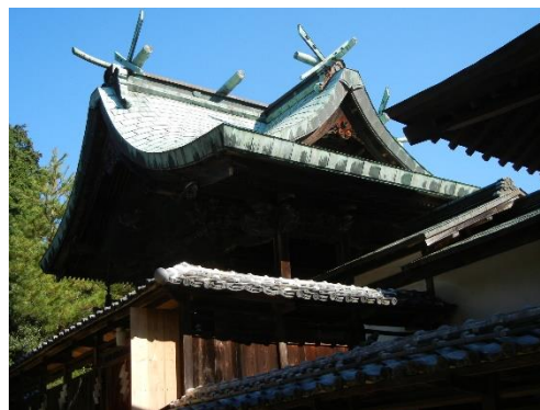
田熊八幡神社本殿
