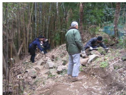
挹翠園跡調査風景
