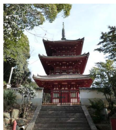
西國寺三重塔（重要文化財）
