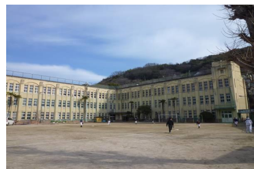
久保小学校（昭和8年建築）
