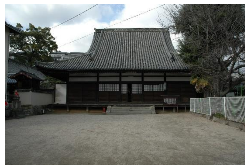
常称寺本堂（重要文化財）
