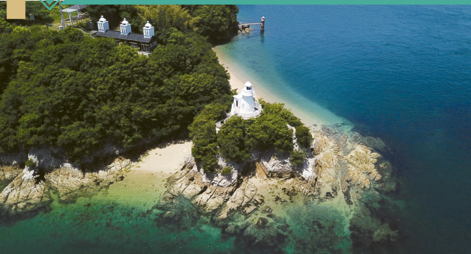
▲旧大浜埼通航潮流信号所施設 (撮影 村上宏治)
