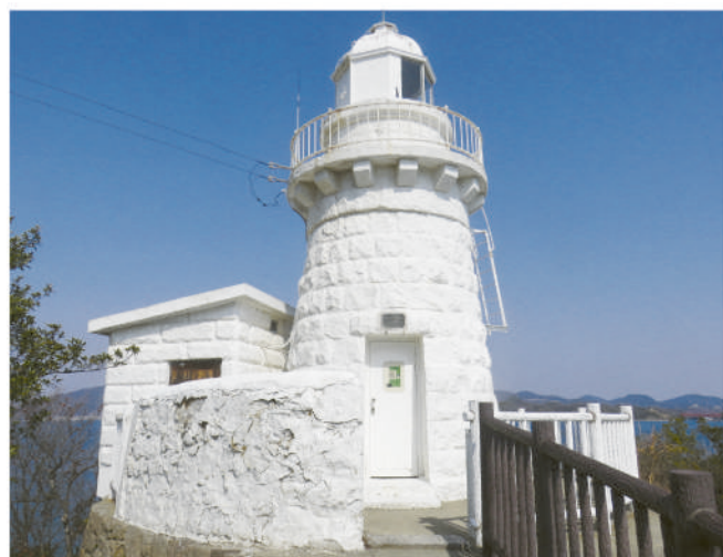
▲夜間潮流信号塔 (大浜埼灯台)
