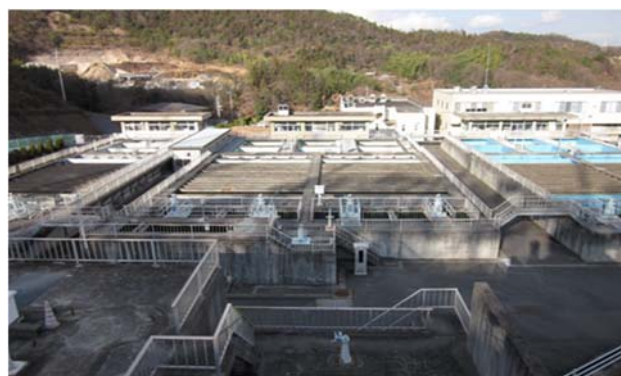
図 2.2 坊士浄水場（沼田川水道用水供給事業）
