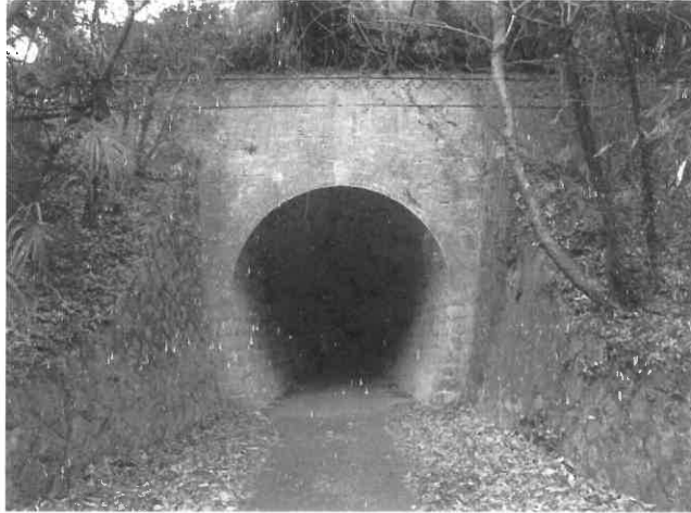
木ノ庄町に残る尾道鉄道第4号トンネルの遺構 山中 仁氏撮影
