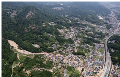
▲平成30年7月豪雨での被害の様子
