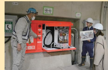
2本あるトンネルの総延長は約2.2kmと、開通区間の約6割を占めます。車両火災発生時に確実に放水できるよう、50mおきに消火設備を配置しています。
