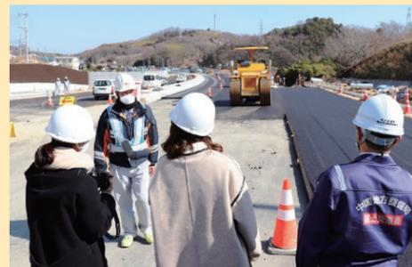
雨の日、タイヤと路面の間に水の膜ができ、スリップ事故の原因となる、ハイドロプレーニング現象が起こりにくい、排水性の良い舗装を敷設しています。
