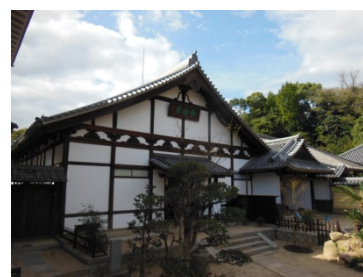
浄土寺保存修理後の様子
