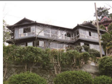
みはらし亭（保存修理後）
