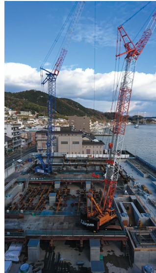
本庁舎屋上から見た建設現場の様子 (平成30年12月時点)
